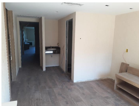
Apartamentos Bloco C
