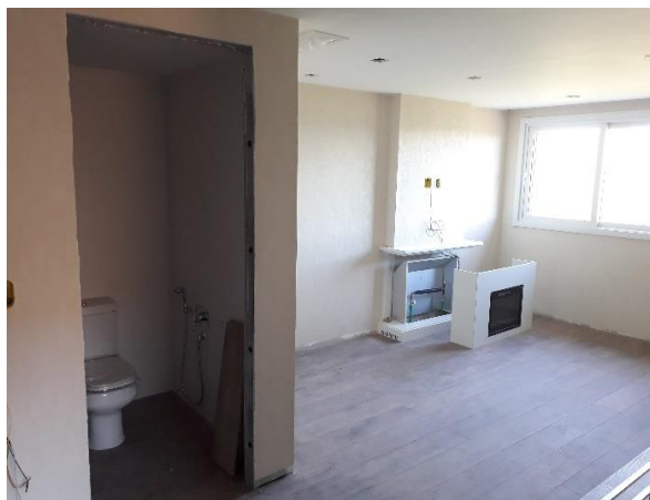
Apartamento Bloco C
