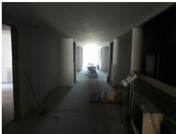
Circulação subtelhado Bloco D
