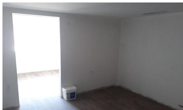
Apartamento subtelhado Bloco D
