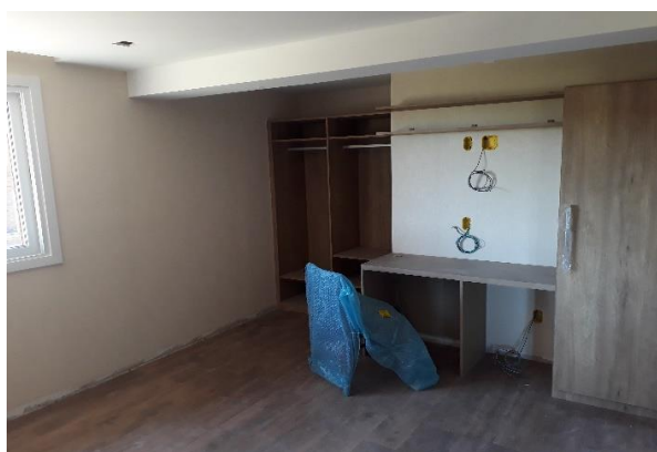
Apartamentos Bloco C
