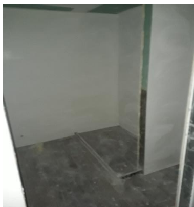
Banheiro 1ºss Bloco D
